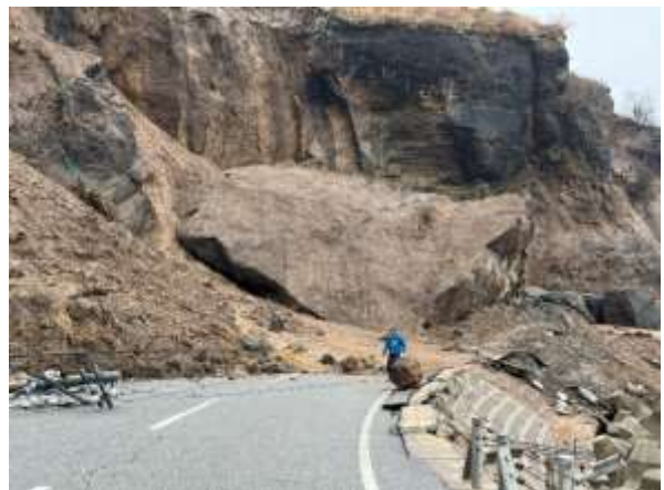
大岩崩落、深見地区への道路遮断・孤立
